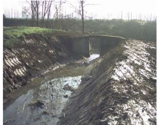
Figura 125 – Colatore Reale in prossimità della chiavica (sinistra) e recente intervento di manutenzione del manufatto di scarico di un colatore secondario nel Colatore Reale in comune di Chignolo Po (destra).
