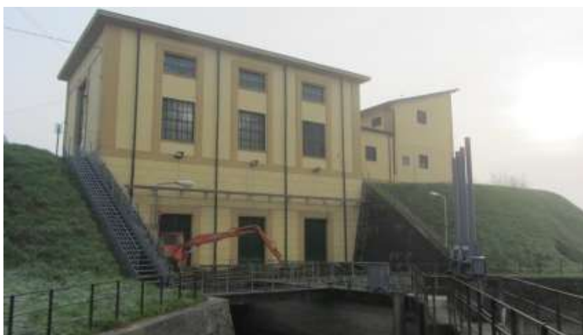
Figura 122 – Chiavica del Reale: edificio lato campagna.
