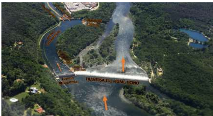
Figura 61 – Nodo idraulico presso lo sbarramento di Panperduto sul fiume Ticino.
