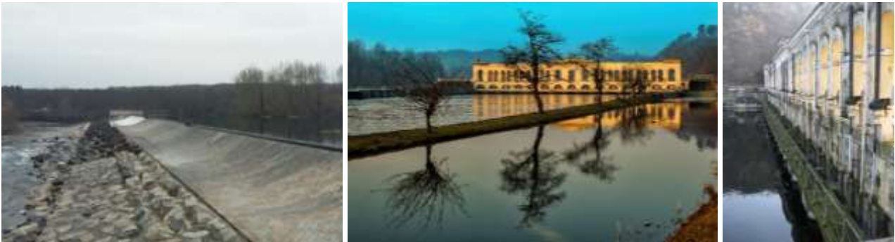
Figura 62 – Traversa sul Ticino con sovralti gommati (sinistra); edificio regolatore visto da valle (centro) e visto da monte (destra).
