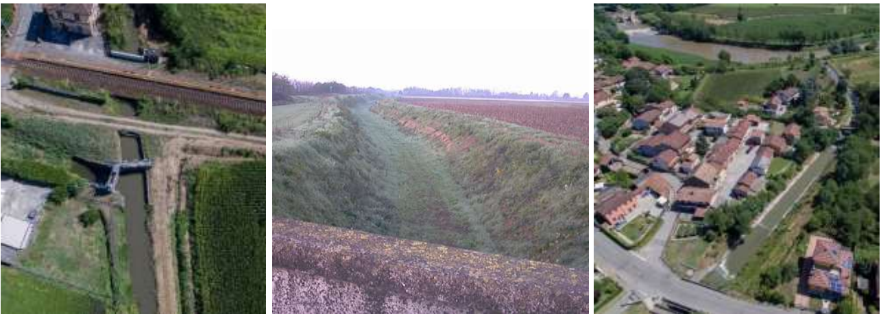
Figura 124 – Canale Deviatore: manufatto iniziale (sinistra) e tratto in comune di Santa Cristina e Bissone (centro); tratto degli scivoli prima di sfociare nel fiume Lambro in località Lambrinia del comune di Chignolo Po (destra).
