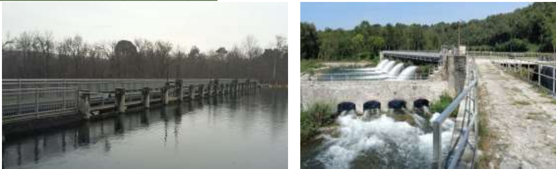
Figura 63 – Scaricatore dei 120 m³/s visto da monte dall'interno del bacino (sinistra) e visto da valle (destra).
