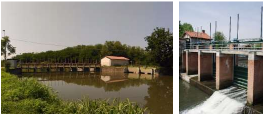
Figura 72 – Traversa di Casa Fulvia a Costa dei Nobili (PV) per la derivazione del Cavo Ravano, e traversa a Cura Carpignano (PV) per la derivazione della Roggia Molina dal Fiume Olona Meridionale.
