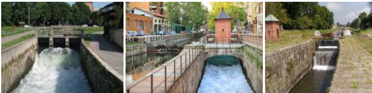
Figura 71 – Sbarramenti in linea per la regolazione delle portate irrigue del Naviglio Grande: Conca del Dazio dismessa sul Naviglio di Bereguardo ad Abbiategrasso (sinistra), Conchetta sul Naviglio di Pavia a Milano con conca di navigazione funzionante (centro), Conca del Confluente dismessa sul Naviglio di Pavia a Pavia (destra).
