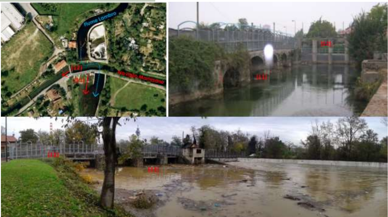
Figura 134 – Nodo di via Idro a Milano: Manufatto (11) di regolazione dello scarico dal Martesana nel fiume Lambro e manufatto (12) in linea di regolazione del Naviglio Martesana (sopra); vista da valle nel Lambro con scarico attivo (sotto).
