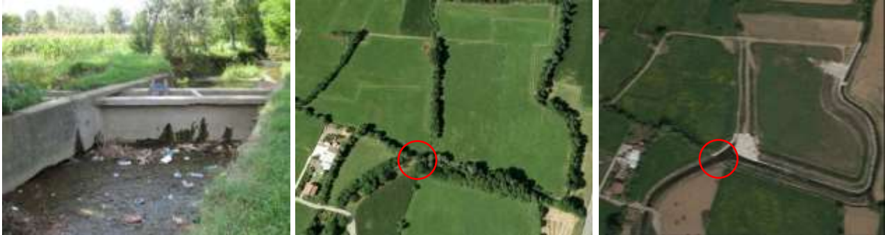
Figura 136 – Pontecanale della Roggia Crosina sulla Roggia Trobbia (sinistra); stato originario dei luoghi a Inzago (centro) e situazione a vasca di laminazione realizzata con demolizione del pontecanale della Crosina (destra).
