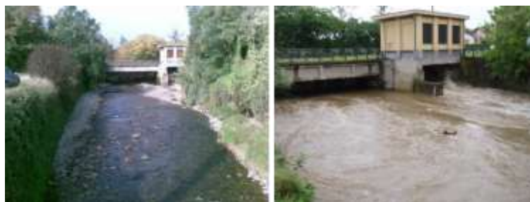
Figura 133 – Manufatto (8) di regolazione dello scarico dal Naviglio Martesana nel torrente Molgora a Gorgonzola: Molgora in magra (sinistra), Molgora in piena con scarico da Martesana attivo (destra).
