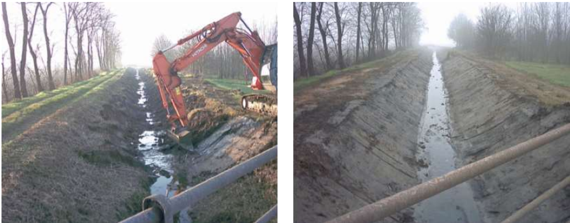
Figura 128 – Intervento di manutenzione
