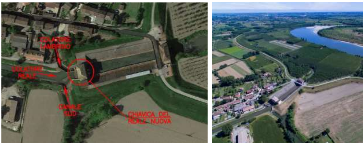
Figura 120 – Foto aerea della Chiavica del Reale e dei canali afferenti (sinistra); panoramica fino al recapito in Po (destra).
