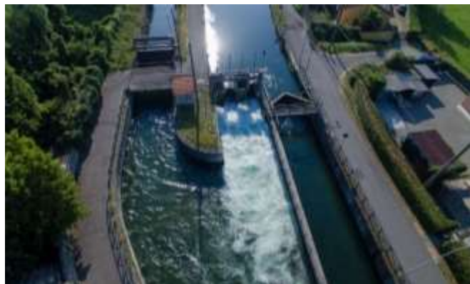
Figura 78 - Sbarramenti in linea per la regolazione delle portate irrigue del Naviglio Martesana: Inzago, Villa Fornaci (con immissione Scolmatore Trobbie in destra idraulica del Naviglio).
