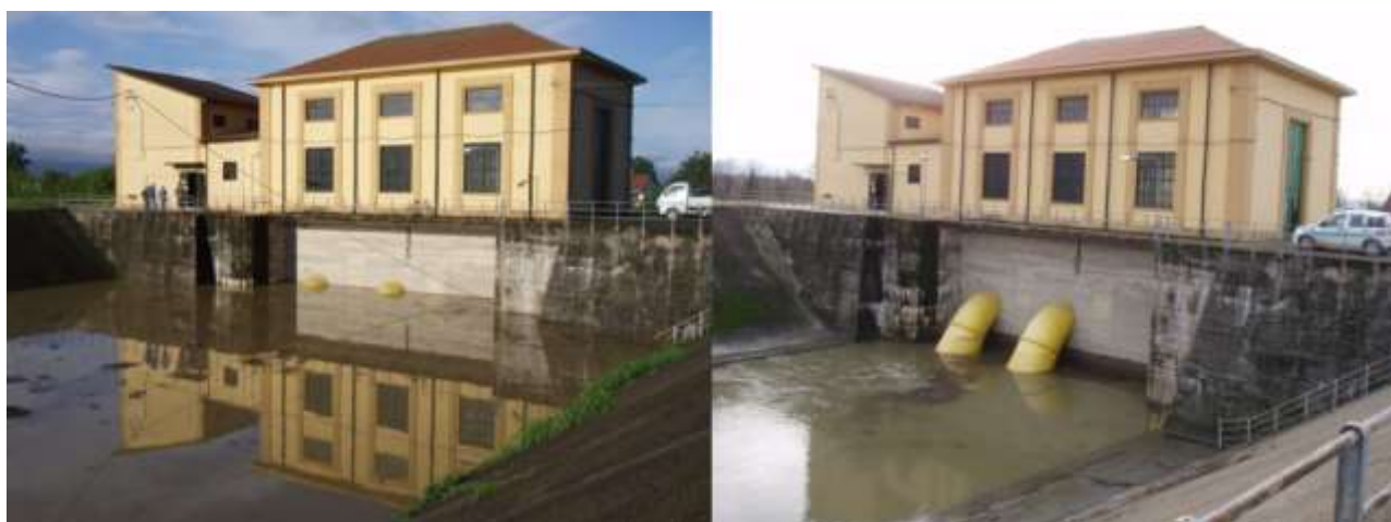
Figura 123 – Chiavica del Reale lato mandracchio: idrovore in funzione durante due momenti di un evento di piena.
