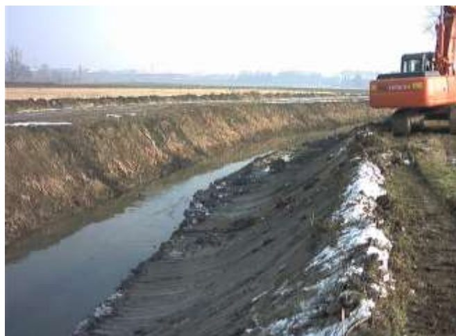
Figura 127 – Intervento di manutenzione del colatore Roggione.
