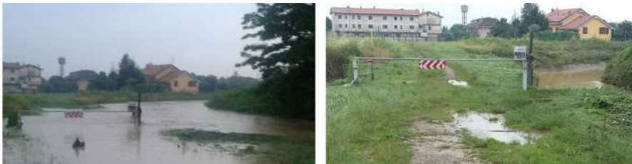
Figura 131 – Manufatto (6) di alimentazione della Roggia Trobbia a Villa Fornaci in comune di Bellinzago: piena rilevante con sormonto della paratoia per rigurgito da Martesana (sinistra), evento ordinario con portata accettata nel Martesana.
