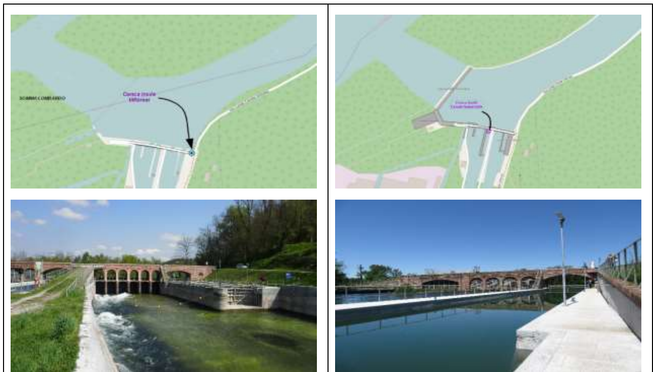
Figura 151 – La conca incile Canale Principale Villorresi (a sinistra) e la conca Incile Canale Industriale (a destra).
