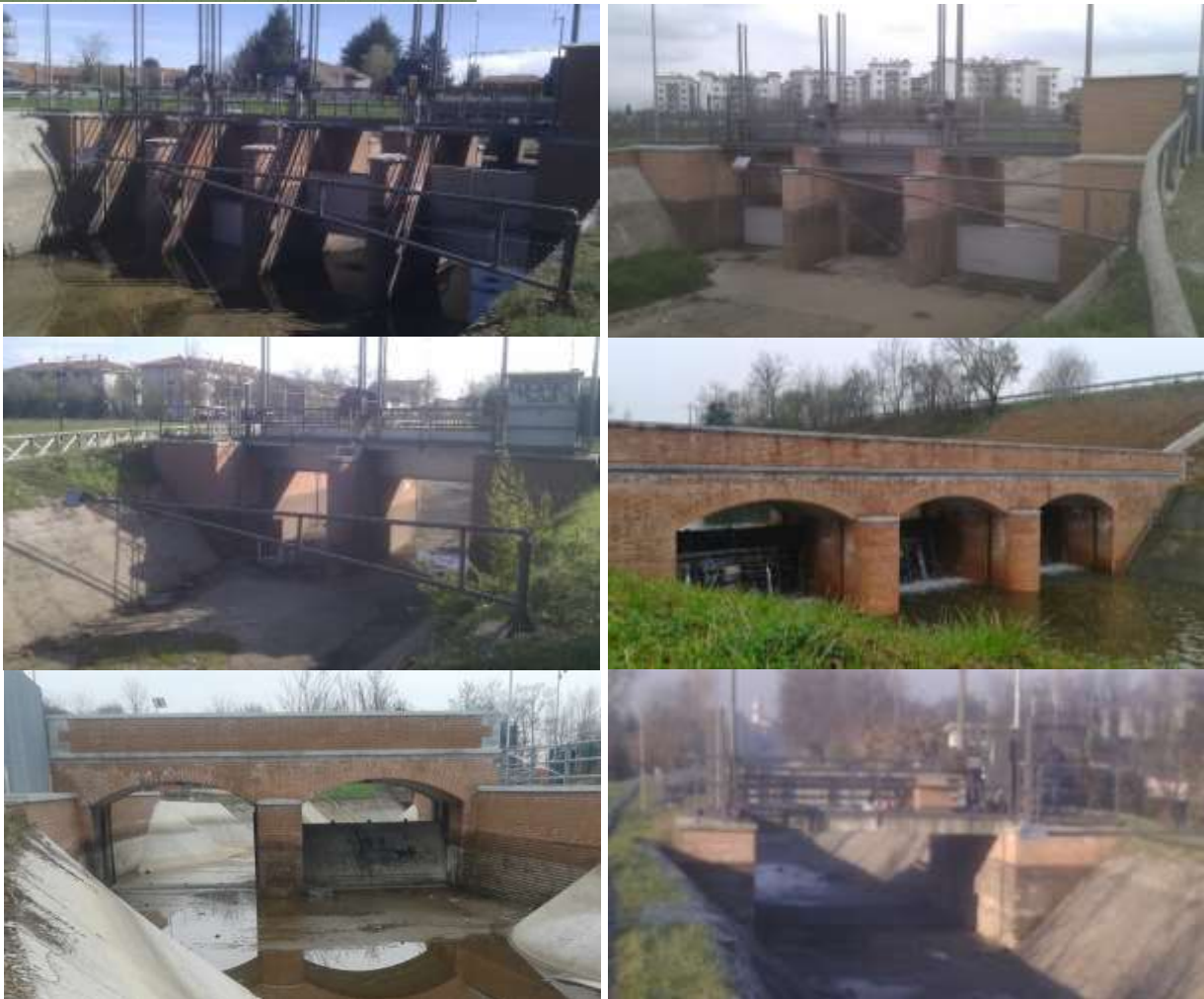
Figura 66 – Sbarramenti in linea per la regolazione delle portate irrigue del Canale Villoresi: Tura di Arconate e Tura di Parabiago (in alto), Tura di Garbagnate e Tura di Nova (al centro), Tura di Monza 1 e Tura di Monza 2 - tubone (in basso).
