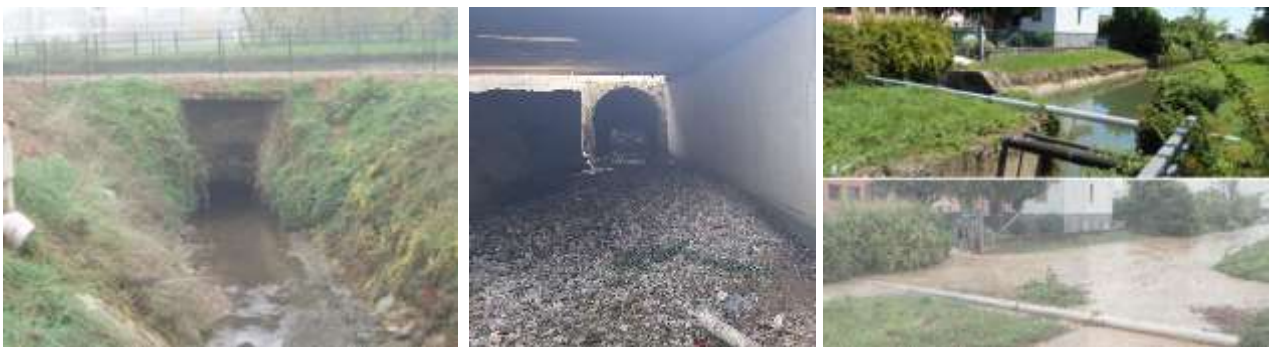
Figura 135 – Interferenze principali del reticolo Trobbie: Sottopasso (5) della Roggia Trobbia sotto il Naviglio Martesana (sinistra); Sottopasso (8) del Torrente Trobbia-ramo di Gessate sotto la ex SS 11 Padana Superiore e sotto il Naviglio Martesana (centro); Ponte stradale della ex SS 11 Padana Superiore sullo Scolmatore e sulla Roggia Trobbia (destra).
