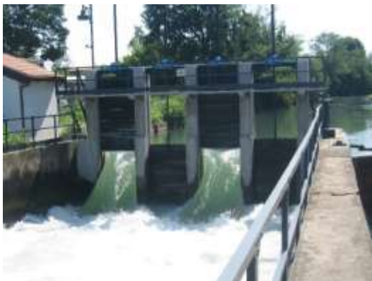
Figura 78 - Sbarramenti in linea per la regolazione delle portate irrigue del Naviglio Martesana: Inzago, Villa Fornaci (con immissione Scolmatore Trobbie in destra idraulica del Naviglio).
