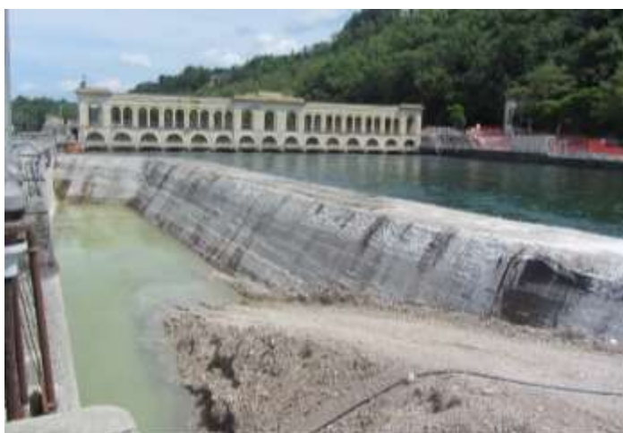
Figura 112 – Edificio di presa Dighe del Panperduto.
