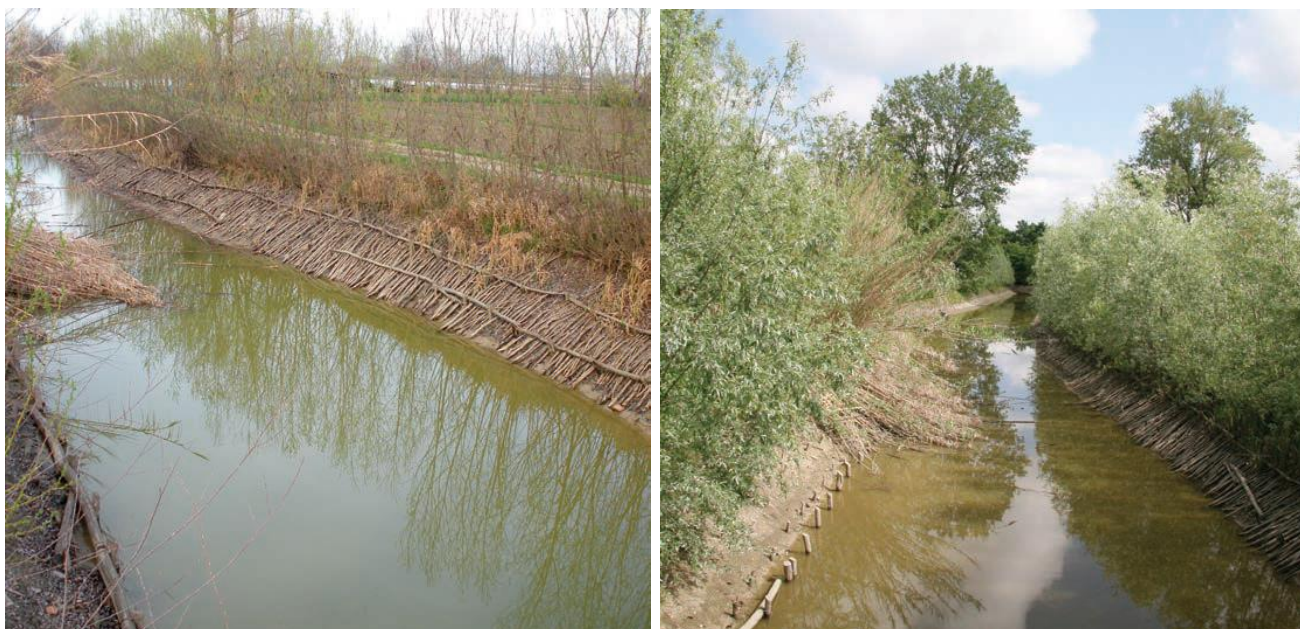
Fig. 7-8 – Copertura diffusa con astoni di salice: Canale di Migliarina durante i lavori e dopo 5 anni (Fonte: Linee Guida Riqualificazione Canali, Regione Emilia Romagna)
