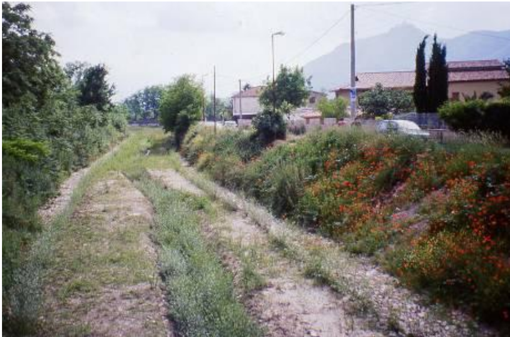
Fig. 8 - Realizzazione di savanella di magra nel caso di portata scarsa e intermittente per concentrare le acque per il mantenimento degli habitat igrofilii . Acque concentrate in un alveo di magra. Rio Inferno Cassino (FR). Foto P. Cornelini
