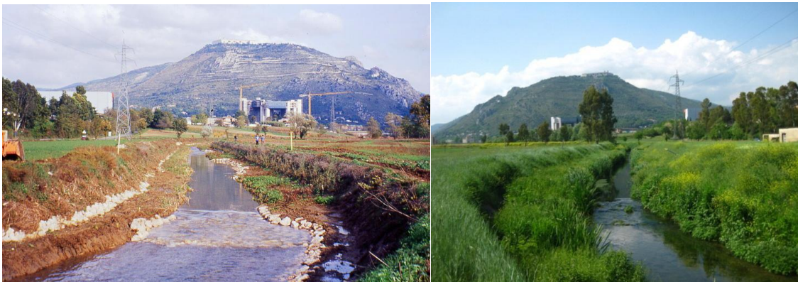
Fig. 2-3 Rio Fontanelle Cassino( FR): Rinaturalizzazione all'interno dell'alveo artificiale di pianura con impossibilità di esproprio per realizzare una fascia igrofila ripariale (Fonte: Linee Guida Riqualificazione Canali, Regione Emilia Romagna)
