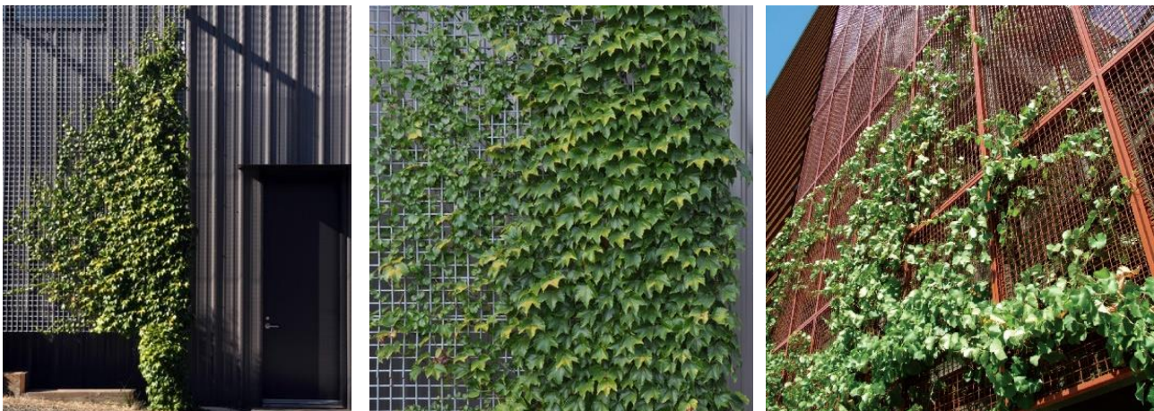
Fig. 2-4- Rampicanti per il mascheramento di elementi tecnologici
