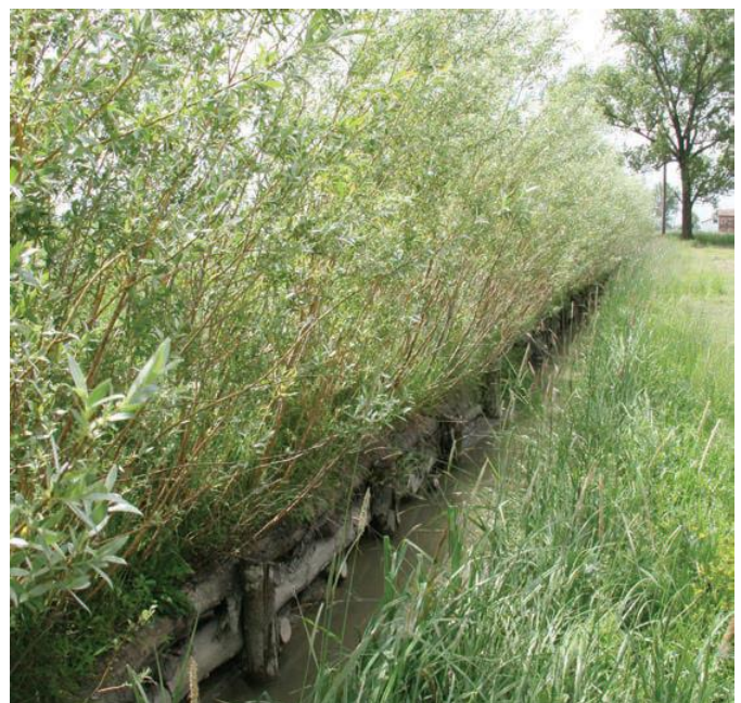
Fig. 5-6 – Fossetta dei Morti, Carpi. Prima dei lavori e dopo 5 anni dalla realizzazione della palificata viva (Fonte: Linee Guida Riqualificazione Canali, Regione Emilia Romagna)
